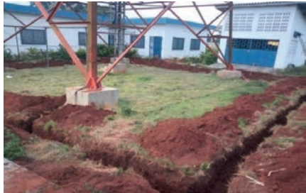
Travaux d'excavation autour de la station fixe
